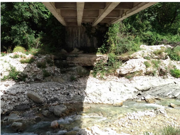
Foto pre intervento
