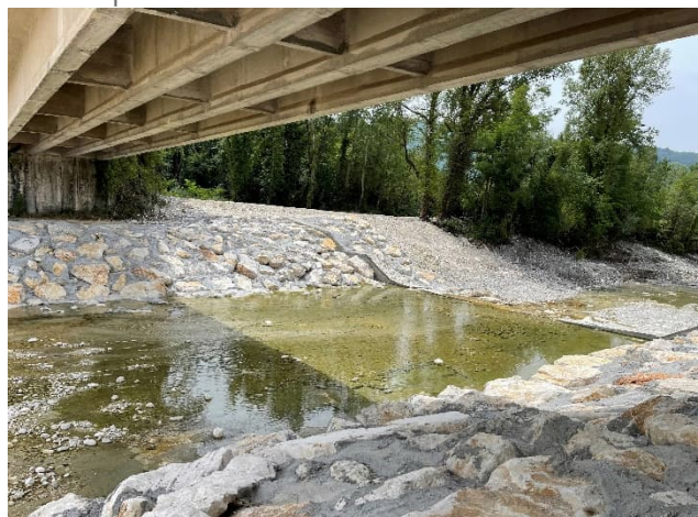
Foto post intervento
